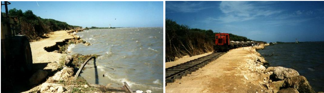
Figura 2. Deslizamiento en el Dique Boyacá, noviembre 1999
