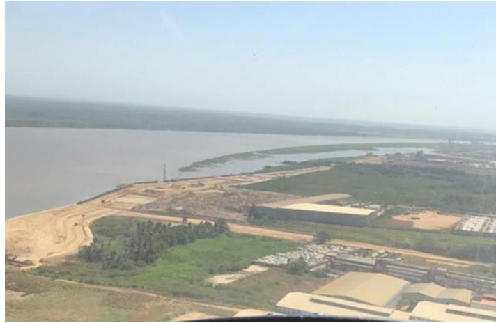
Figura 8. Sedimentación Margen Izquierda Gran Malecón – Avenida del río (Enero 2019)
